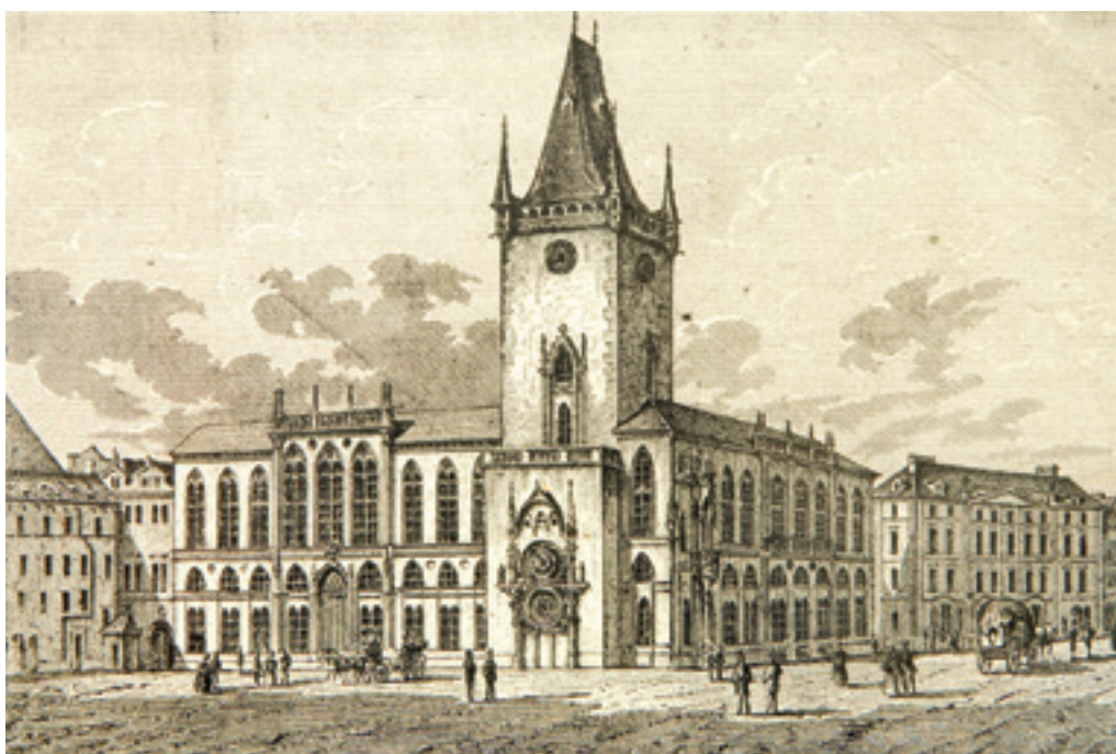
Obr. 4. Praha 1-Staré Město, čp. 1, Staroměstská radnice. Ideální představa Nobileho přestavby radnice, po 1841. Plán královského českého hlavního města Prahy. Malebně romantické zobrazení královského českého hlavního města Prahy v 62 obrazech nejvýznamnějších paláců, kostelů, soukromých budov a krásných partií okolí, se čtyřmi situačními plány od Karla hr. Vasquezze Pinase, nedatováno (1842–1845), navržený hrabětem Vasquezem Pinasem; Fr. Weis (sc.); tisk Lud. Förster (repro P. Havlík, 2012).
