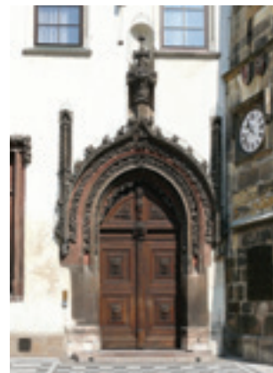
Obr. 52. Praha 1-Staré Město, čp. 1, Staroměstská radnice. Hlavní vstupní vrata, celek, asi 1616, úprava 1652 (foto autor, 2007).
