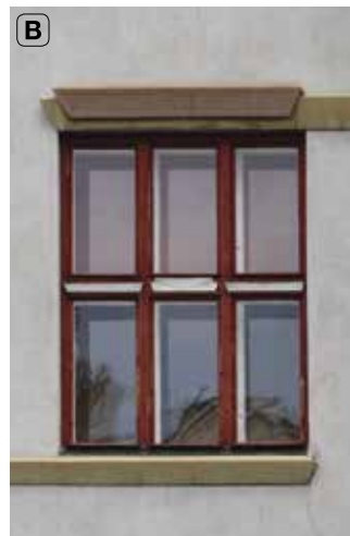
Obr. 19. Praha 1-Staré Město, čp. 123, 1021/I, Elišky Krásnohorské 10, 12. Okna v úrovni 2. patra na západní straně uliční fasády v místě styku obou domů. A – okno domu čp. 1021 je kopií s nově provedenou barevností; B – okno domu čp. 123, které je původní (foto autorka, 2020).
