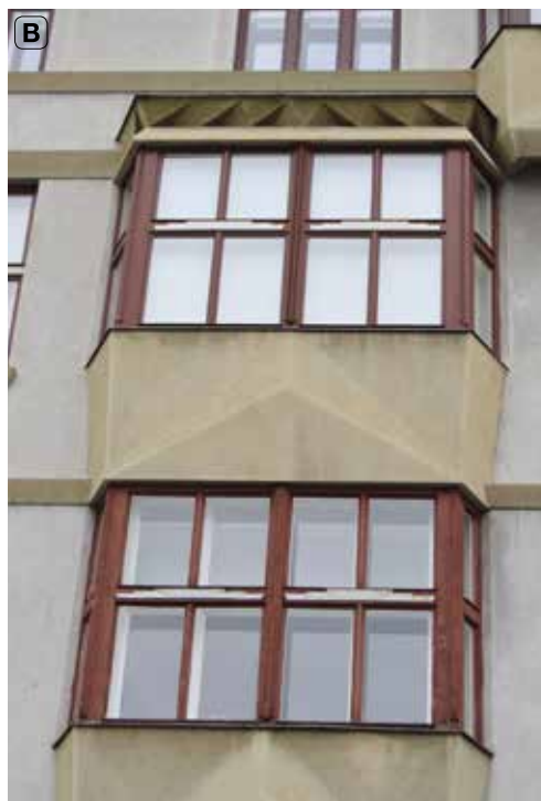
Obr. 18. Praha 1-Staré Město, Elišky Krásnohorské 10, 12. A – část západní uliční fasády domu čp. 1021/I s okny kompletně výměnými za kopie. Diskutabilní je nahnědlý odstín oken, odlišný od původních červených oken dalších dvou domů architektonického celku. B – část západní uliční fasády domu čp. 123/I s arkýřem ve druhé ose zleva – úroveň 2. a 3. patra. Spodní okno ve 2. patře je původní, okno nad ním ve 3. patře je celkem zdařilou kopií. Diskutabilní je opět barevnost povrchového nátěru, která se liší od viditelných barevných souvrství na původních okenních křídlech (foto autorka, 2020).
