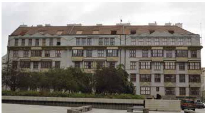
Obr. 17. Praha 1-Staré Město, čp. 123, 1021 a 1037/I, ulice Elišky Krásnohorské 10, 12, 14, Bílkova 5. Celkový pohled na trojici kubistických Učitelských domů od Otakara Novotného z let 1919–1921. Dokumentované výplně okenních otvorů ve schodišti jsou součástí prostředního domu čp. 1021 (foto autorka, 2016).
