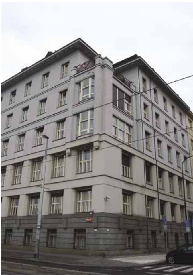
Obr. 4. Praha 2–Nové Město, čp. 390/II, Rašínovo nábřeží 42, budova bývalého Všeobecného penzijního ústavu z let 1913–1914 od Jana Kotěry a Josefa Záscheho. Pohled na jihozápadní nároží směrem od Vltavy se zdařilou částečnou výměnou oken za kopie v letech 2012–2013 (foto autorka, 2020).
