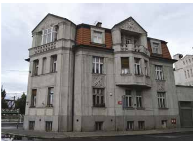
Obr. 2. Praha 2-Vyšehrad, čp. 50/VI, Rašínovo nábřeží 26. Celkový pohled od jihu. Dům byl postaven v letech 1912–1913 podle návrhu Emila Králíčka. V roce 2004 byla povolena výměna dožilých částí oken (foto autorka, 2020).
