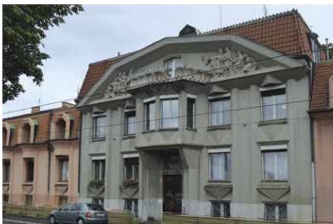
Obr. 1. Praha 2-Vyšehrad, čp. 47/VI, Rašínovo nábřeží 8. Celkový pohled od Vltavy na uliční fasádu rodinného domu. Stavba je součástí celku tří kubistických domů od Josefa Chochola z let 1912–1913. Na dotčeném domě byla vyměněna okenní křídla, ostatní dva domy mají prvky ještě původní (foto autorka 2020).
