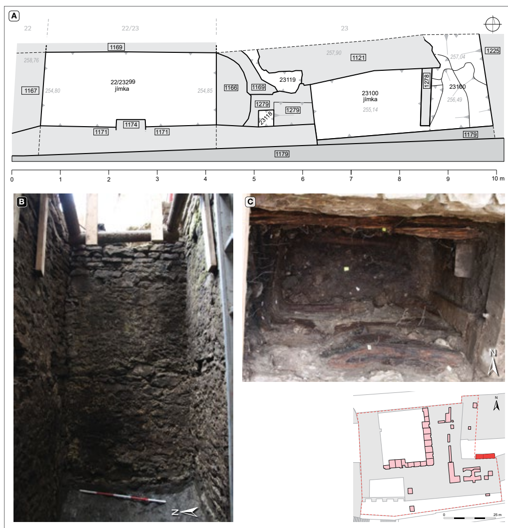
Obr. 54. Praha 1, Hradčanské nám. čp. 186/IV – Salmovský palác. A – zaměření odpadních jímek 22/23 a 23; B – zděná konstrukce odpadní jímky 22/23; C – odpadní jímka 23 – výdřeva a spodní část výplně jímky, pohled shora (sestavil F. Adáamek, 2024; foto © Archeo- logický ústav AV ČR, Praha, 2009).
