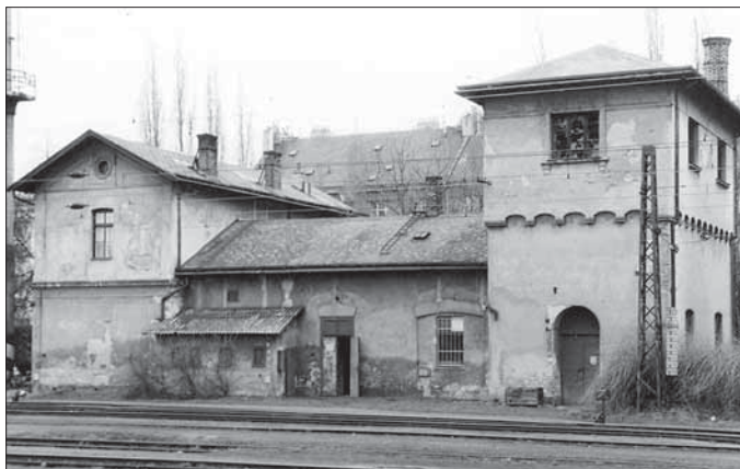
Obr. 2. Praha 10-Vršovice, čp. 305, nádraží, bývalá vodárna s vodojemem, celkový pohled. U jednotlivých částí budovy je patrné odlišené architektonické členění fasád, stav 2002 (foto K. Fink).
