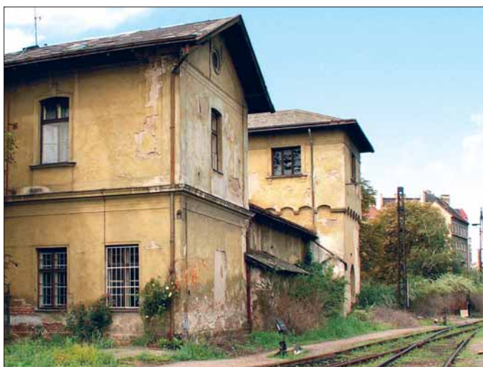
Obr. 3. Praha 10-Vršovice, čp. 305, vodárna, detail fasád, stav 2007 (foto Z. Pospíchalová).
