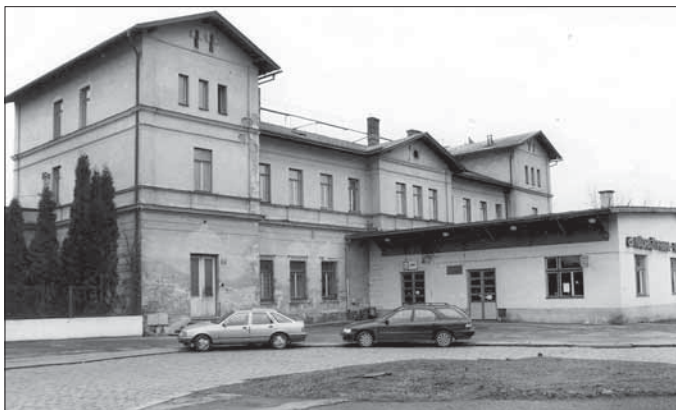
Obr. 6. Praha 10-Vršovice, čp. 304, nádraží, hlavní průčelí před obnovou, s přístavbou čekárny. Na fasádě přízemí patrný stopy po původním architektonickém členění, stav 2002 (foto K. Fink).
