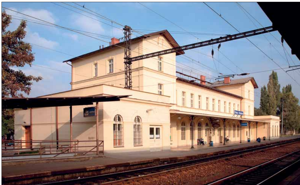
Obr. 4. Praha 10-Vršovice, čp. 304, nádraží, fasáda ke kolejišti po obnově 2009, celkový pohled (foto P. Havlík).
