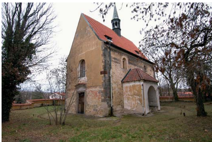
Obr. 1. Praha 8-Dolní Chabry, kostel sv. Jana Křtitele. Pohled od jihozápadu (foto M. Tryml, 2010).
