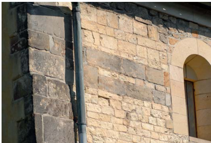
Obr. 5. Praha 8-Dolní Chabry, kostel sv. Jana Křtitele. Pohled na jihozápadní nároží kostela se zřetelným uskočením nárožní lizény (foto M. Tryml, 2011).
