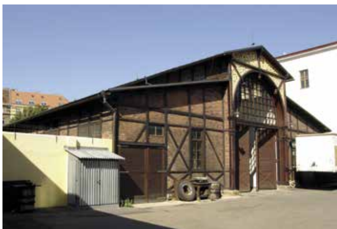
Obr. 3. Praha 3-Vinohrady, čp. 973, budova městských jatek a tržnice masa (foto J. Baláček, 2009).
