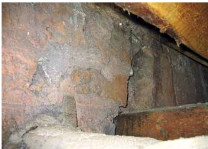
Obr. 18. Praha 1-Malá Strana, kostel P. Marie pod řetězem. Západní partie jižní stěny protaženého presbytáře. Zřetelné je kvádrkové zdivo s podřezávanými spárami, do kterého byly druhotně prolámany ostění gotických oken (foto autor, 2010).
