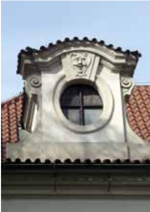
Obr. 8. Praha 1-Malá Strana, čp. 485, Velkopřevorský palác. Pohled na barokní vikýřové okno č. 3 z exteriéru (foto P. Havlík, 2013).
