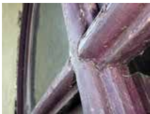
Obr. 14. Praha 1-Malá Strana, čp. 485, Velkopřevorský palác. Detail vikýřové výplně č. 1 – křížení oblounových profilů, pohled z exteriéru (foto D. Havlíková, 2013).
