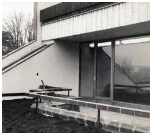
Obr. 8. Praha 6-Dejvice, čp. 2450, Sušická 20. Celkový pohled na experimentální buňku (foto M. Kracík, 2013).
