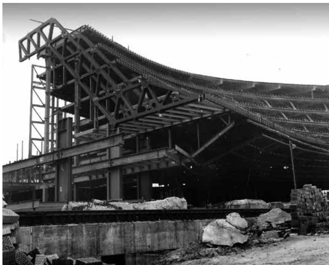
Obr. 3. Praha 6-Dejvice, čp. 2450, Sušická 20. Pohled na stavbu objektu s patrným použitím kombinace ocelové konstrukce, příhradových nosníků a železobetonových stropních desek (foto archiv prof. A. Navrátila).
