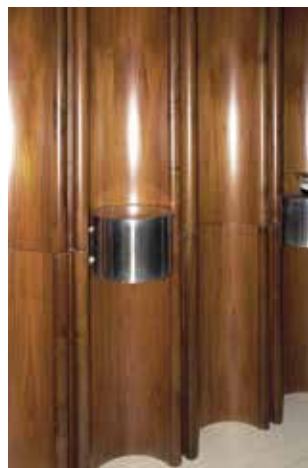
Obr. 31. Praha 6-Dejvice, čp. 2450, Sušická 20. Prostor bazénu – kout s občerstvovacími stoly vsazenými do jednotlivých mohutných kanelur dřevěného obložení (foto autorka, 2013).
