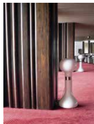
Obr. 22. Praha 6-Dejvice, čp. 2450, Sušická 20. Pohled do prostor bývalé snidárny v suterénu s mohutnými nosnými sloupy obloženými kanelovaným dřevěným obkladem, s lamelovým podhledem a s původními stojacími lampami od autora K. Volfa (foto autorka, 2013).
