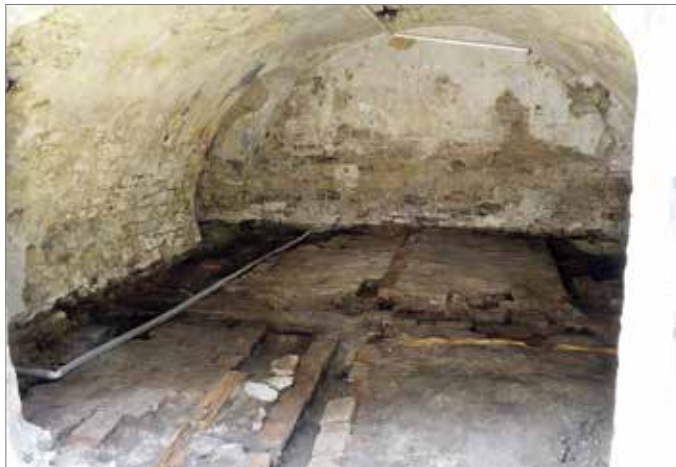
Obr. 4. Praha 1-Staré Město, čp. 212, prostor bývalé stáje. Pohled k severu po začištění cihelné podlahy (foto M. Semerád, 2012).
