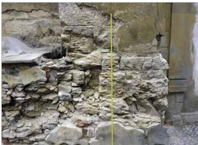
Obr. 3. Praha 1-Staré Město, kostel svatého Jakuba, sokl jižní strany presbytáře. Zdivo čela východního opěrného pilíře před částečnou destrukcí a náhradou nejpoškozenějších opukových kvádrů (foto L. Bartoš, 2011).
