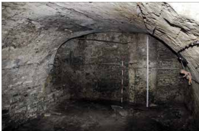
Obr. 1. Praha 1-Nové Město, čp. 1091, sklep. Pohled na severní stěnu (foto H. Černá, 2011).
