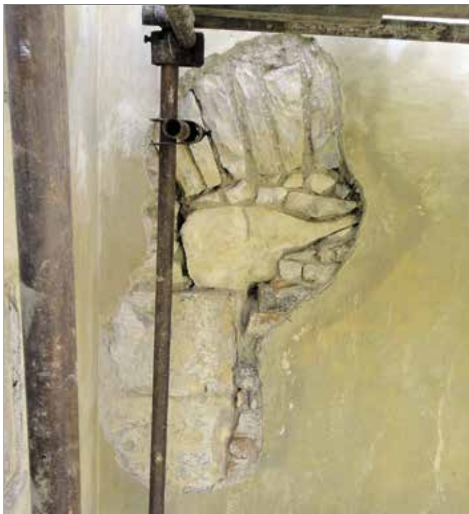
Obr. 2. Praha 1-Staré Město, kostel svatého Ducha, severní fasáda. Pohled na zazděné okno v prvním poli fasády lodí od západu (foto L. Bartoš, 2012).
