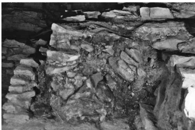
Obr. 9. Pražský hrad, kostel Panny Marie. Příčný řez kostelem ve směru sever-jih, severní část, stejná situace jako na řezu C – obr. 8, dobře viditelná destrukce zdiva tumbly (foto J. Frolík, 21995; archiv ARUP, č. neg. 90167).
