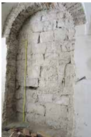
Obr. 7. Praha 1-Staré Město, čp. 930, kvádříkový líc západní obvodové zdi románského domu odhalený po levé straně bývalého průjezdu (foto M. Semerád, 2014).
