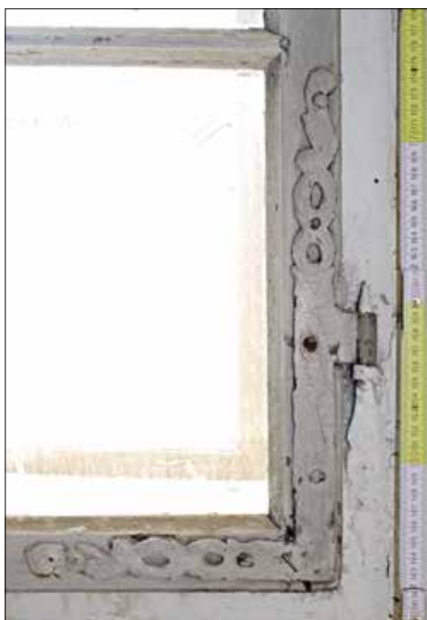
Obr. 1A. Praha 1-Hradčany, čp. 112, pohled zevnitř na pozdně barokní okno ve druhém patře (kresba V. Koberová, 2014).
