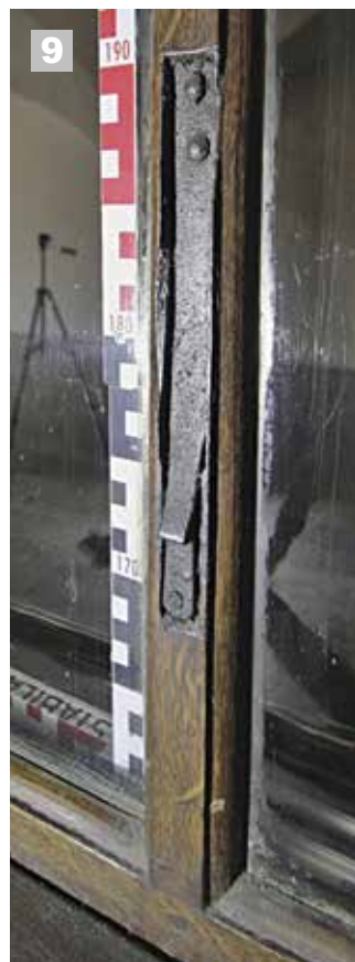
Obr. 7. Praha 1-Staré Město, kostel sv. Jiljí. Detail kování okna č. 1 – rohovníky, knoflík se štítkem, jednoramenný obtřík, kroužek (foto L. Bartoš, 2015).
