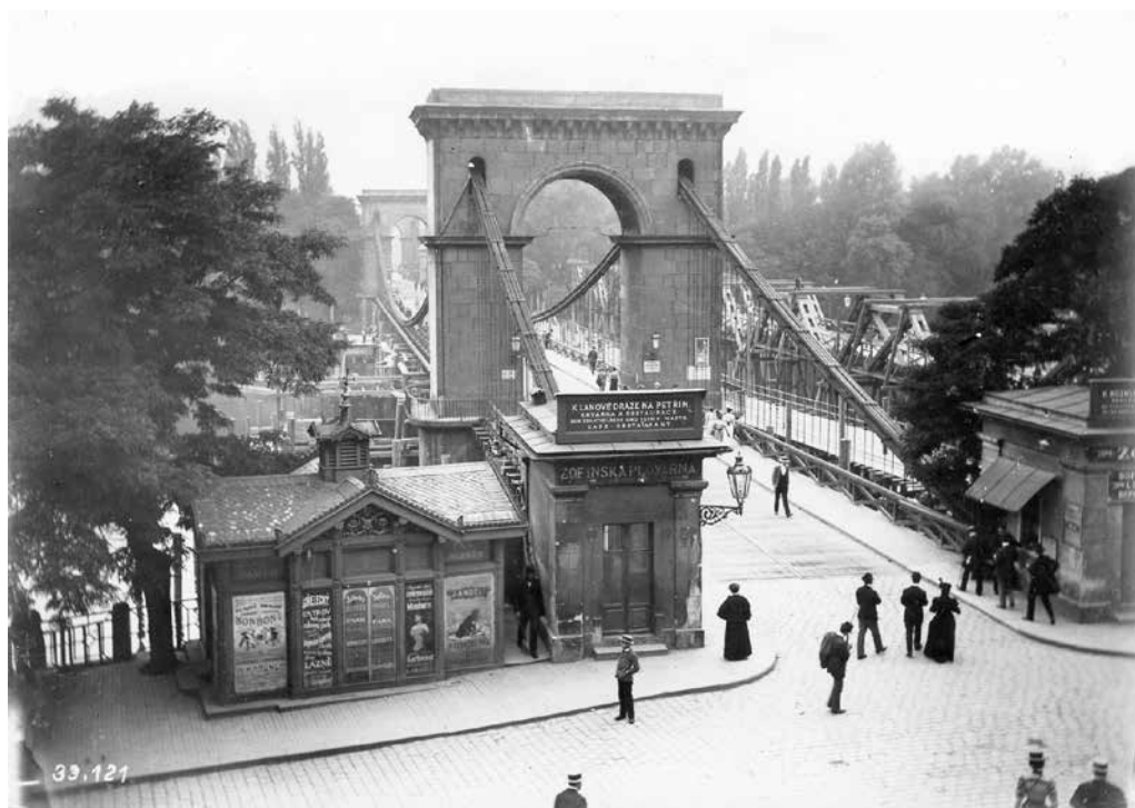
Obr. 10. Východní konec mostu – vyústění na staroměstský břeh před Národním divadlem. Most ukončují výběrčí domky, pod něž zabíhají napínací části kotevnic řetězů. V pozadí za mostem (severně) se již buduje provizorní dřevěný most jako náhrada za krátce poté demolovaný most Františka I., na jehož místě bude postaven stávající most Legií. Uloženo: fotodokumentace NPÚ GnŘ, N039121.
