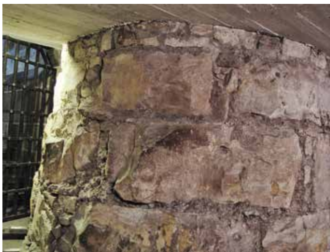
Obr. 1. Pražský hrad, katedrála sv. Víta. Opukové zdivo základu pilíře při kapli sv. Kříže v prostoru suterénu před královskou hrobkou (foto autor, 2013).
