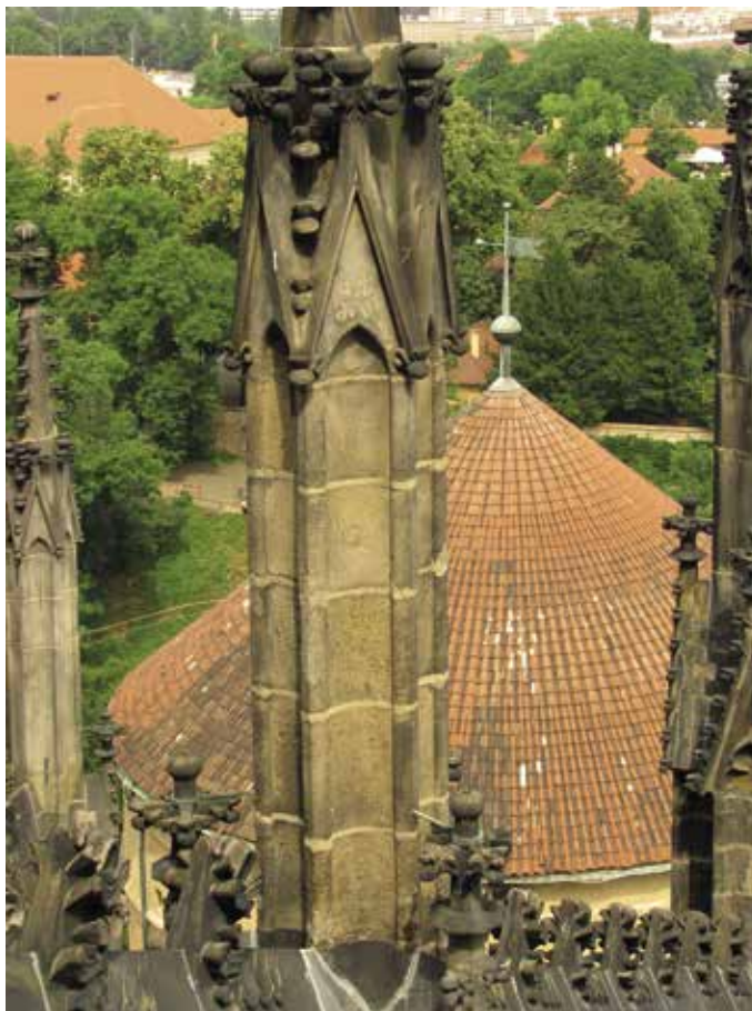
Obr. 3. Pražský hrad, katedrála sv. Víta. Vrcholová fiála jednoho z opěrných pilířů severní strany vysokého chóru, jejíž dřík je složen z dílů vytesaných z hrubozrné žehrovické arkózy (foto autor, 2014).
