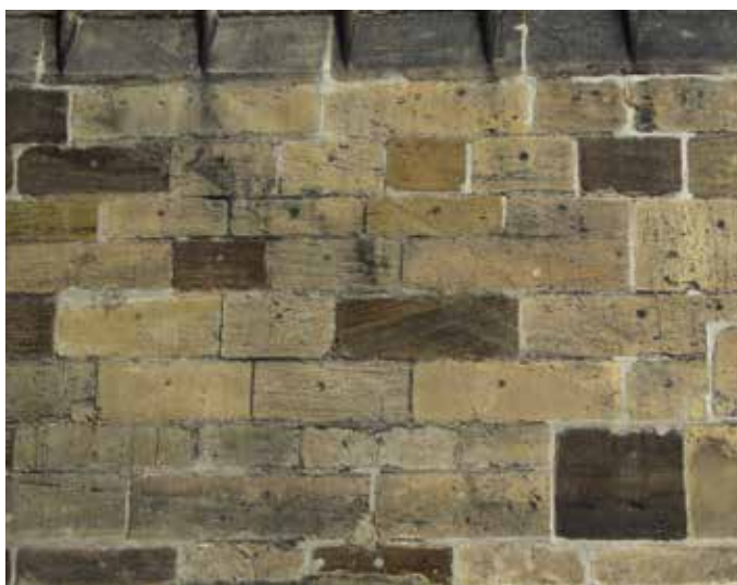
Obr. 2. Pražský hrad, katedrála sv. Víta. Nadzemní zdivo západní stěny předsíně jižního portálu (Zlaté brány) z pískovců různé barvy a struktury (foto autor, 2015).
