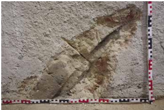
Obr. 13. Praha 2-Nové Město, kostel Panny Marie sv. Karla Velikého na Karlově. Pohled na nalezené gotické pískovcové články ve východní zdi pod podlahou zvonice (foto L. Bartoš, 2016).
