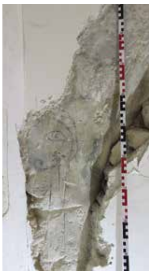
Obr. 8. Praha 1-Nové Město, čp. 753, františkánský klášter. Část nalezeného gotického portálu v JV koutu ambitu (foto L. Bartoš, 2016).
