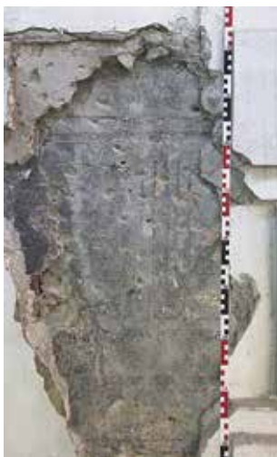
Obr. 4. Praha 1- Malá Strana, čp. 205, Nerudova 2, Zámecká 1. Odhalená část sgrafitové fasády při severním konci východní fasády (foto L. Bartoš, 2016).
