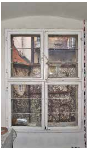
Obr. 3. Praha 1-Malá Strana, čp. 163, Valdštejnské náměstí 2. Pohled na okno ze schodiště (foto V. Koberová, 2016).
