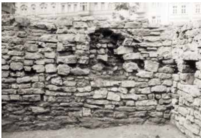
Obr. 1. Praha 1-Staré Město, Rybná čp. 682/I, ppč. 690, výzkum NPÚ ÚOP v Praze č. 1992/22. Interiér břidlicového domu (foto M. Tryml, 1992).
