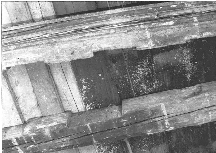
Obr. 6: Druhotně použité trámy pozdně gotického stropu, místnost 1-06.
