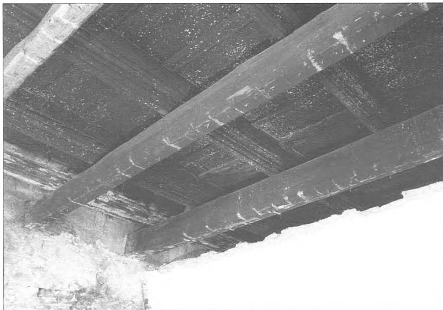
Obr. 2: Pozdně gotický strop v 1. patře (místnost 1-04, 05), strop po sejmutí rákosového pochledu. Foto K. Fink.
