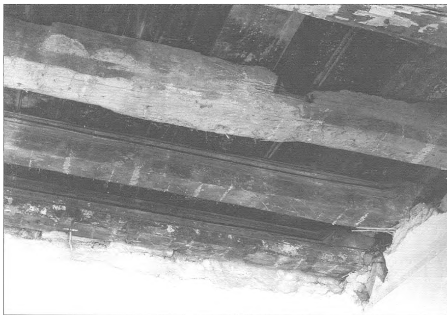
Obr. 7: Místnost 1-06, druhotně použité trámy s patrným přechodem dvojí profilace.
