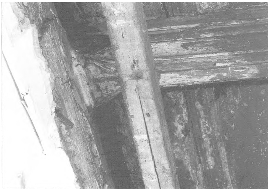
Obr. 5: Pozdně gotický strop v 1. patře (místnost 1-04,05), profilace trámu a zhlaví.
