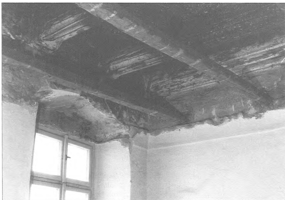
Obr. 3: Pozdně gotický strop v 1. patře (místnost 1-04,05), nasazení stropu nad odhaleným okenním záklenkem. Foto K. Fink.
